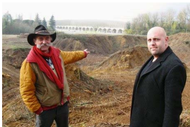
Visible depuis le rond-point du viaduc, le chantier de construction de la piste de karting a pris une tournure spectaculaire. (PHOTO P. L.)
