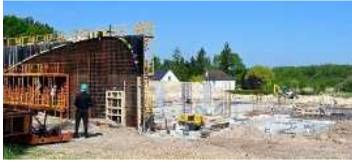
Préparation du coulage du voile de la façade sud.
